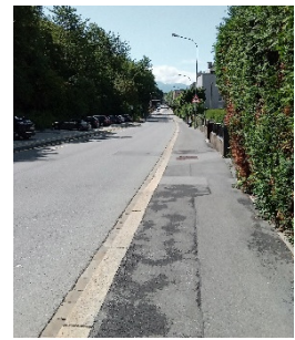
Figure 23 : route du Pavement
